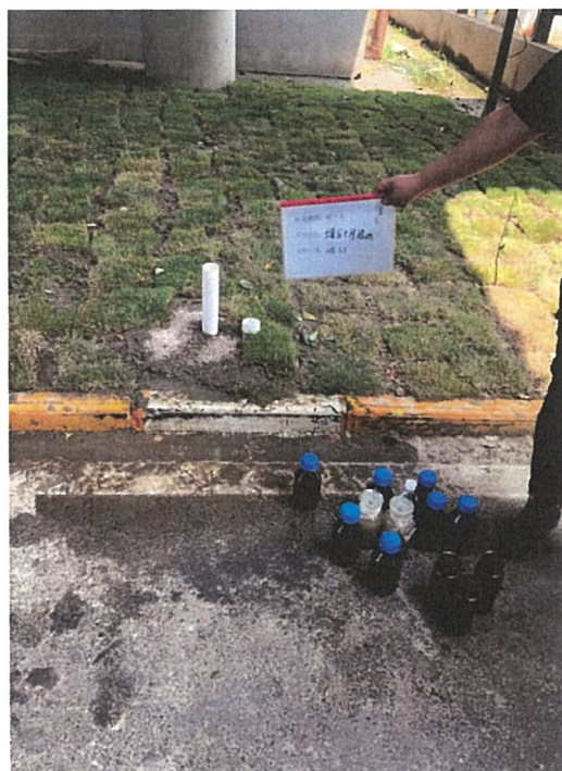
垃圾坑渗滤液收集池+酸碱罐 (D1)
